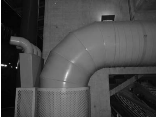
Fig. 1. Imatge esquerra: Conductes de climatització. Palau Sant Jordi (Barcelona). Colze segmentat de 90°.
