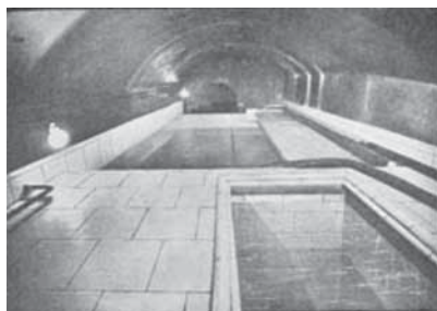
Captación del manantial. Depósitos subterráneos y muros de contención.
