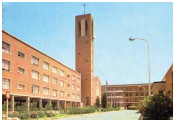
A l'esquerra, el pavelló de nenes, seguit de l'església. I, al fons, tancant la plaça, el pavelló de Llevant d'ancianes. Davant del pavelló de nenes, el teatre. Tots aquests edificis, al perímetre d'aquest espai central, configuren la plaça cívica del recinte. AHDB-Valman, 1962.
