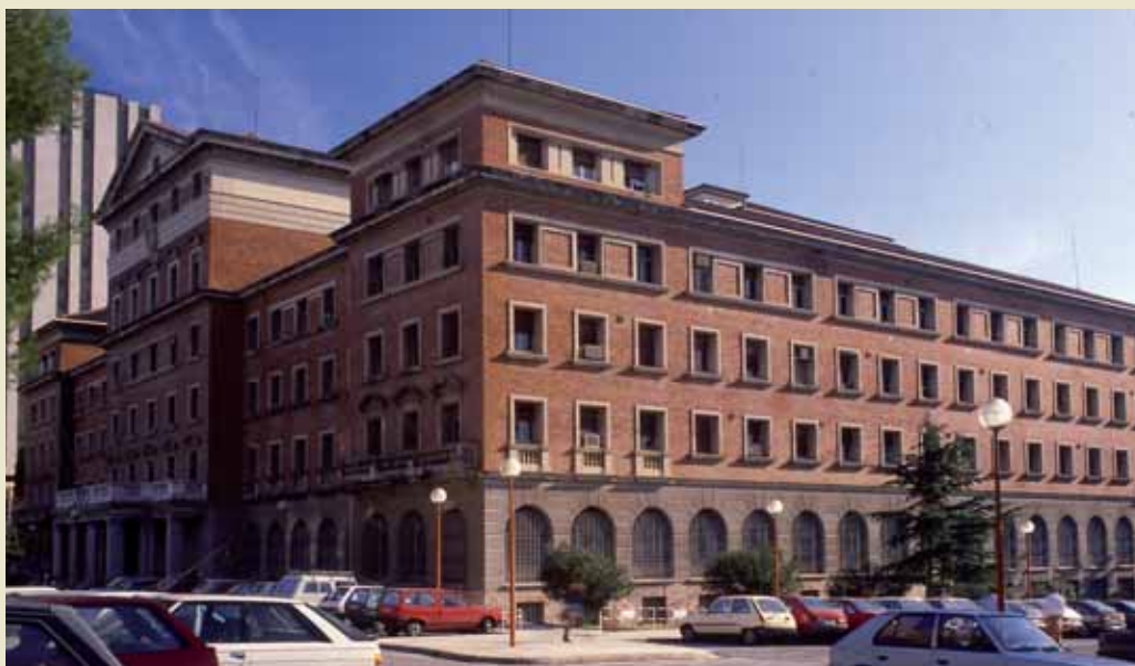
Vista lateral de l'edifici principal de la Facultat de Farmàcia de Barcelona en l'actualitat.
