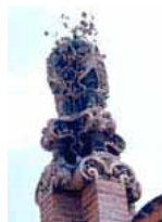
Coronament del pilar que sosté la Porta del Drac
