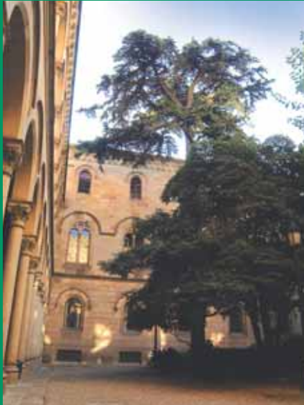
Zona de conexión entre los patios de Letras y de Ciencias
